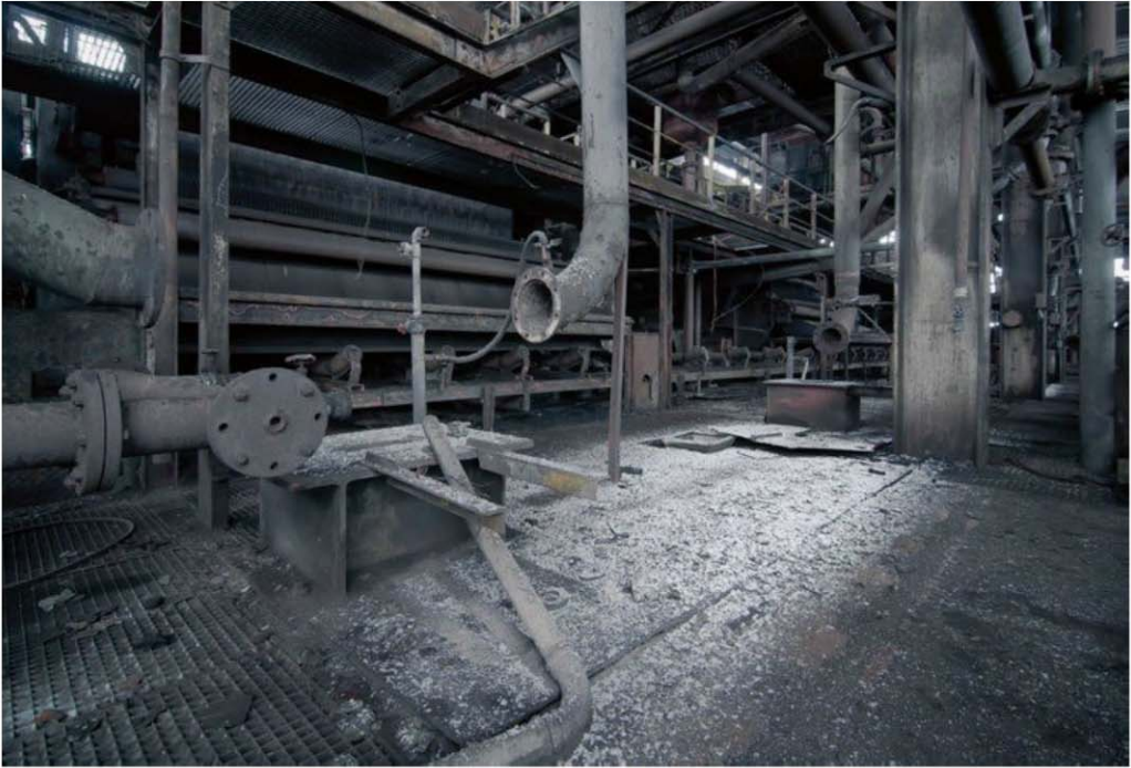
La neige s'infiltré partout, même au cœur de la mine.
