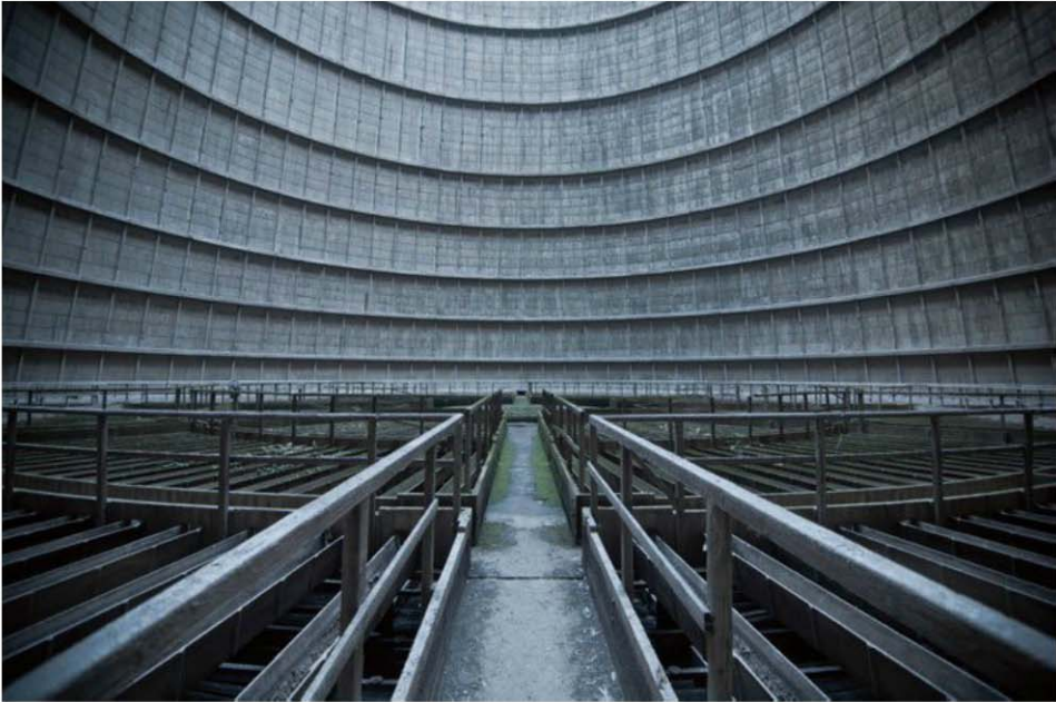
Il est parfois difficile de trouver un angle différent dans une tour de refroidissement. La structure de la tour combinée à la passerelle permet une lecture géométrique.
